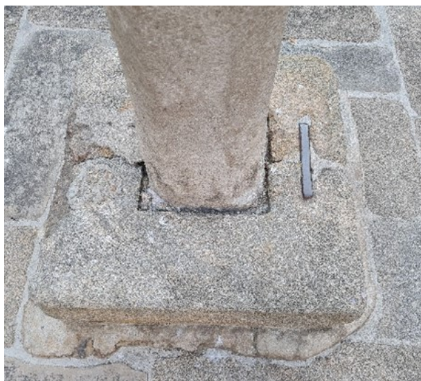
Figura 14: Basamento in granito, particolare dell'assemblaggio tramite lastra in metallo e legante cementizio (Foto di S. Brangi).
