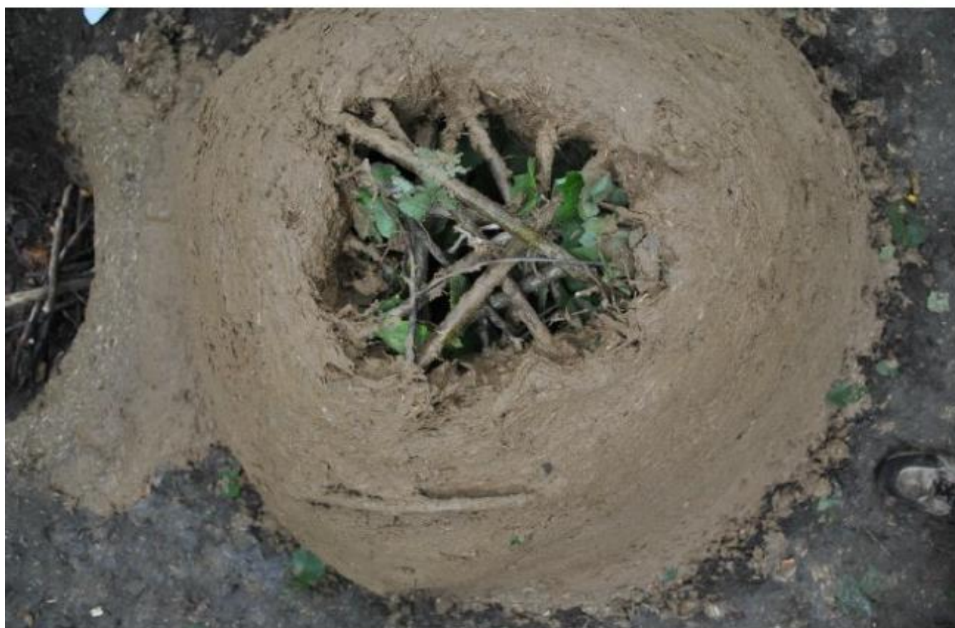
Figura 16: la realizzazione della cupola
