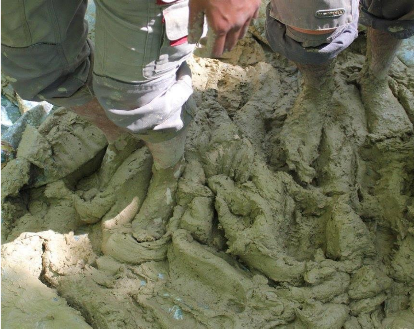
Figura 21: preparazione dell'impasto argilloso.
