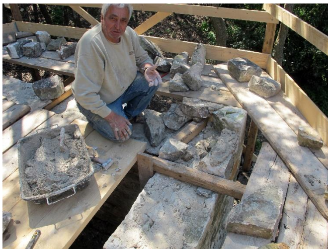
Figura 10: Travi lignee passanti lo spessore della muratura per ponteggi.
