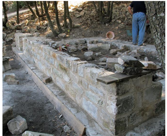
Figura 7: Le fondazioni e il muro di facciata in costruzione.
