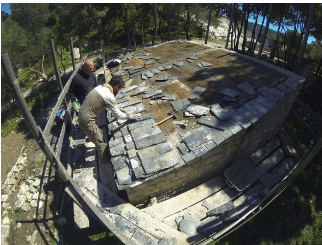
Figura 13: Copertura del tetto in lastre di ardesia.
