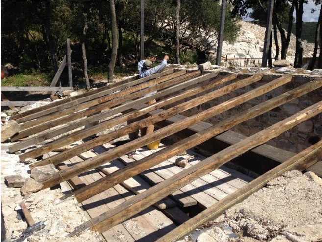
Figura 12: Intelaiatura lignea per il tetto.
