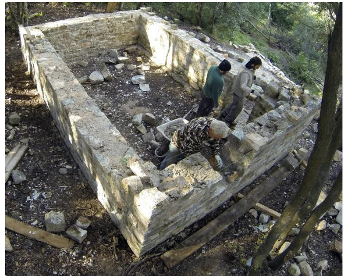
Figura 9: La prosecuzione dei muri a doppio paramento con riempimento interno.
