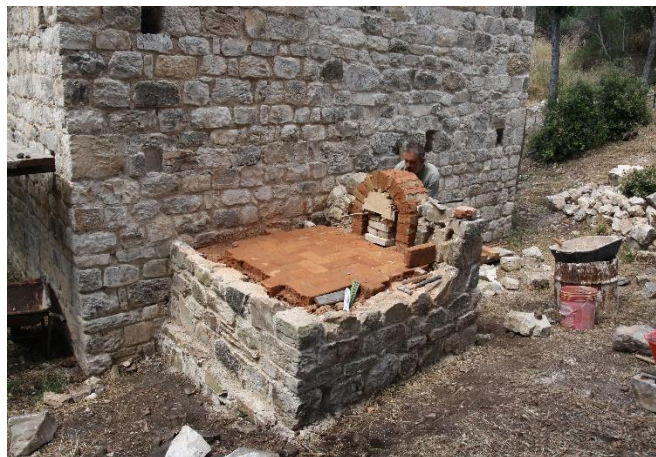
Figura 23: Il piano di cottura in mattoni e l'arco di imboccatura del forno.
