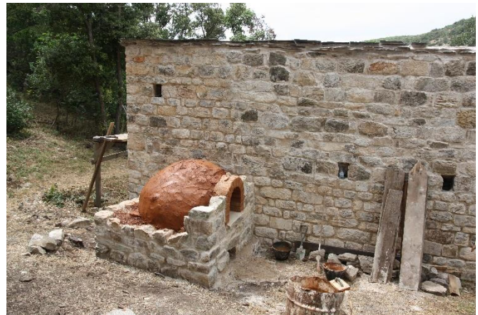
Figura 26: La volta in mattoni e lo strato di argilla isolante.
