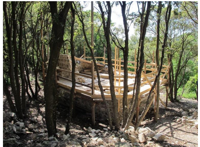
Figura 11: Ponteggi lignei che circondano il perimetro della casa.
