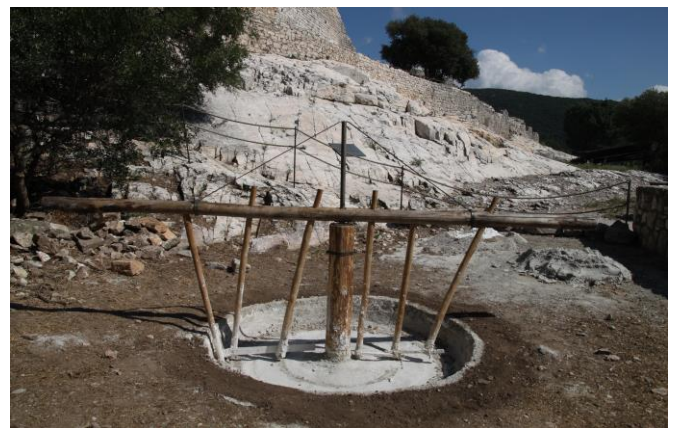
Figura 4: Il miscelatore al termine della costruzione e i miglioramenti effettuati.
