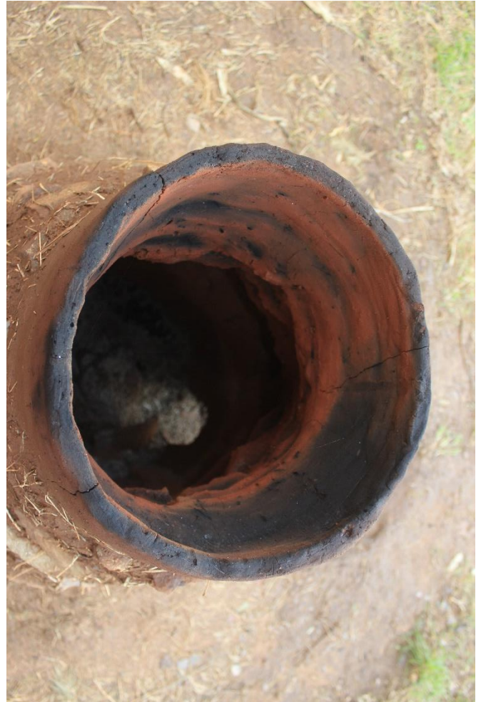
Figura 16: Gli effetti di questa seconda fase: arrossamento superficiale e fessurazione non strutturale del terzo superiore della struttura, le cui pareti risultano essere più sottili.
