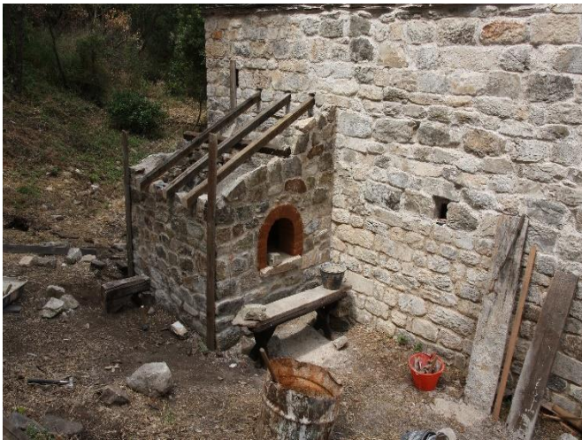
Figura 27: Il completamento dei muri perimetrali e la costruzione della copertura.
