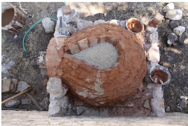
Figura 25: La volta in mattoni poco prima di essere completata.
