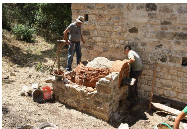
Figura 24: La volta in mattoni in costruzione.
