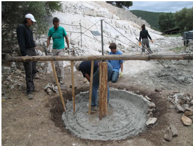
Figura 3: Le tracce impresse sul fondo della vasca del miscelatore in corso di costruzione.
