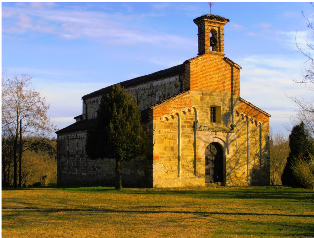
Fig. 1 – Chiesa romanica di San Secondo a Cortazzone (Asti). Esterno. Veduta d'insieme (foto dell'autore).
