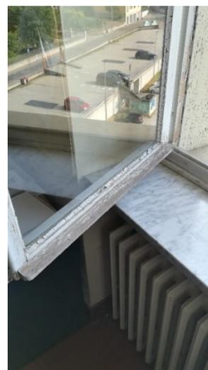
Figura 4: anta sinistra finestra con presenza di mastice
