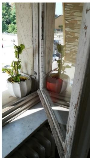
Figura 3: anta destra Finestra con presenza di mastice
